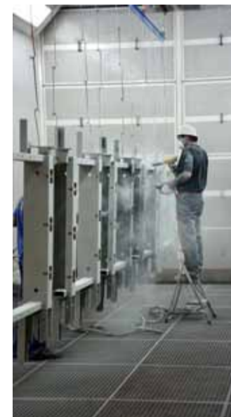
Die Großraum-Pulverkabine ist nicht mit einer Tür, sondern mit einer horizontalen Luftführung zur Kabinenrückwand ausgestattet.
